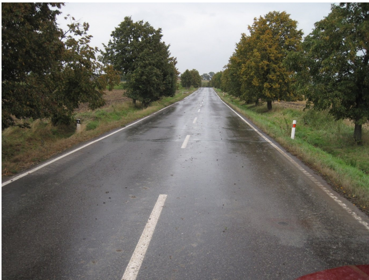
F42, km 18,100+ Příčné trhliny.
