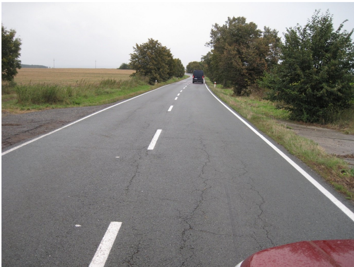
F27, km 16,600+ Mozaikové, příčné, podélné a nepravidelné rozvětvené trhliny, ztráta asfaltového tmelu, hloubková koroze.
