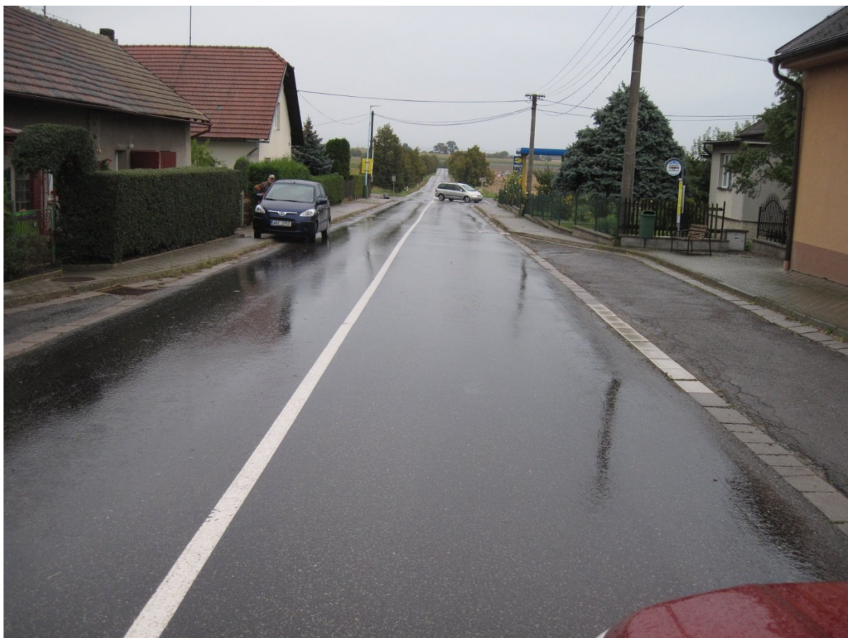
F38, km 17,700+ Drobné mozaikové trhliny u okraje, v ploše autobusového zálivu mozaikové/síťové a nepravidelné trhliny, ztráta asfaltového tmelu a hloubková koroze; intravilán obce Rohenice.
