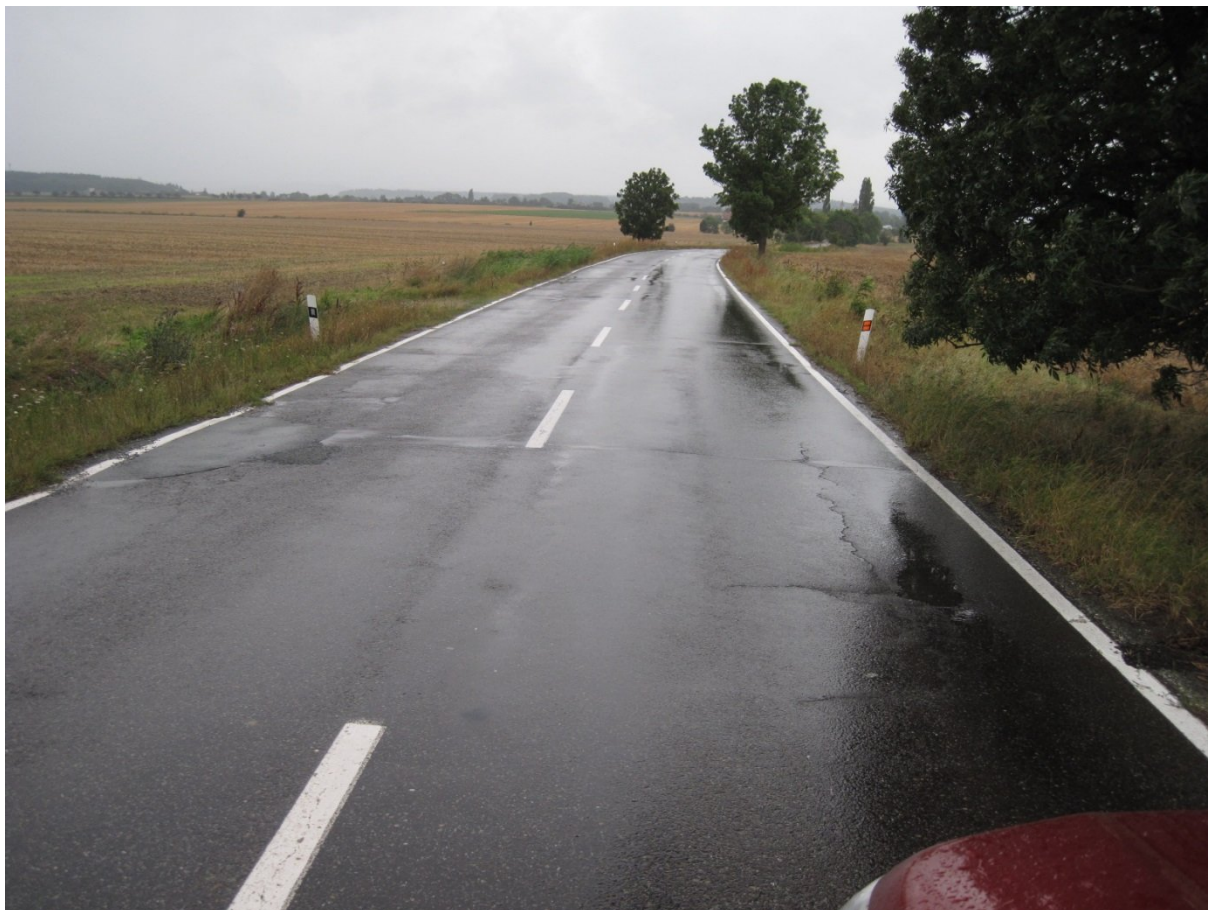
F59, km 19,800+ Mozaikové, příčné a podélné trhliny, vysprávkky, nepravidelné hrboly.
