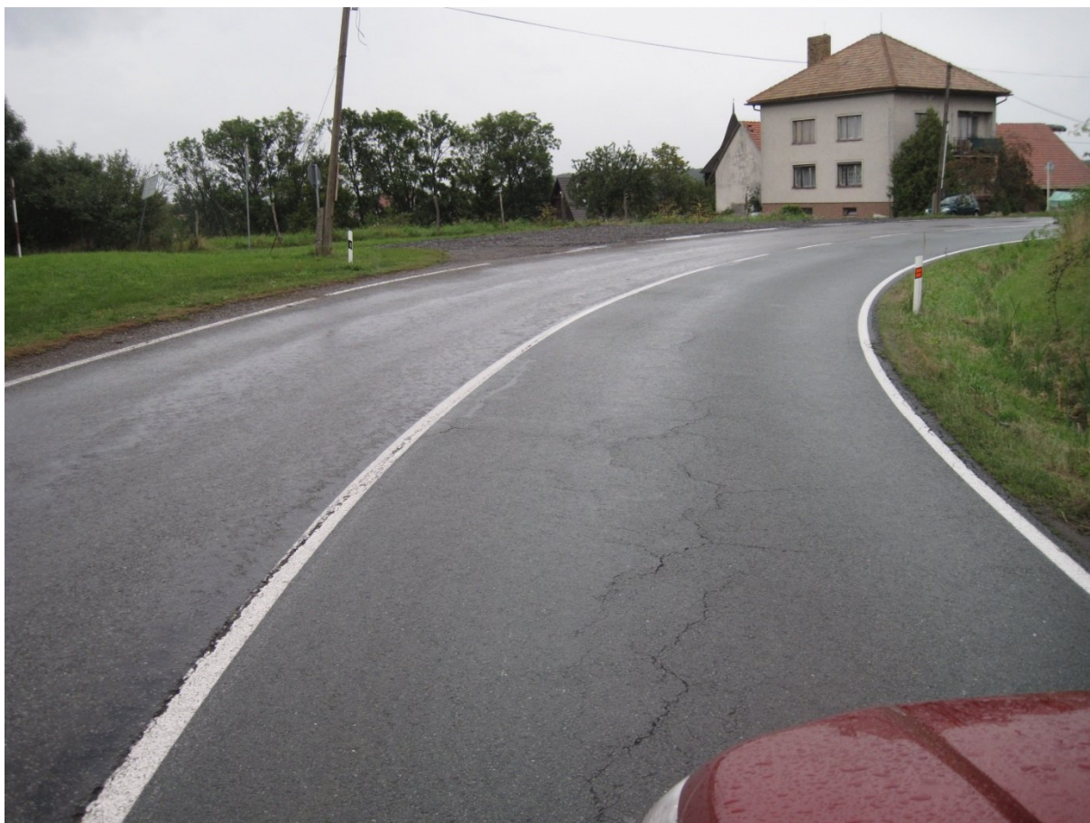
F35, km 17,400+ Mozaikové a nepravidelné rozvětvené trhliny.
