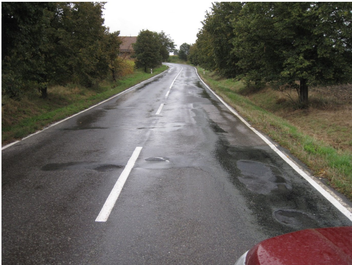
F48, km 18,700+ Vysprávky, nepravidelné hrboly, příčné a podélné trhliny.
